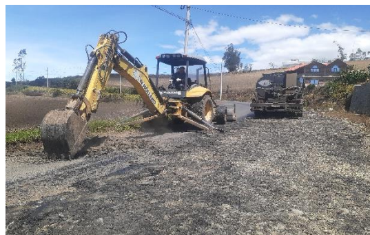
Acompañamiento de trabajos de bacheo de la vía San Simón - Guaranda.
