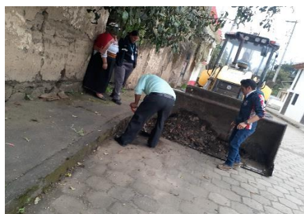
Trabajo de limpieza y fumigación de la cuneta.
