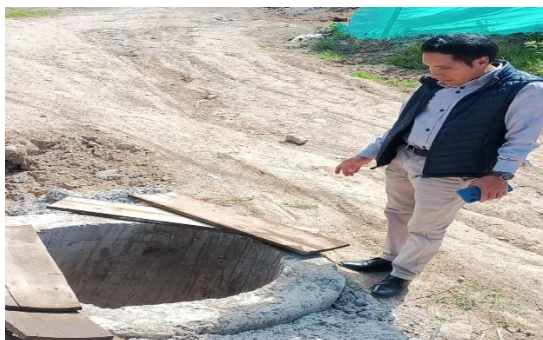
Supervisión de construcción de alcantarillados en el barrio San Vicente.
