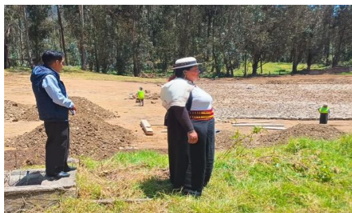
Recorrido y verificación de la construcción parque de la familia.
