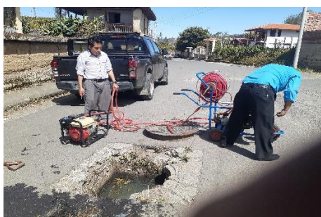
Trabajo de limpieza alcantarillado Barrio San Vicente.
