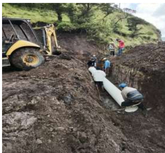
COLOCACIÓN DE ALCANTARILLADO DE AGUAS LLUVIAS COMUNIDAD CACHISAGUA
