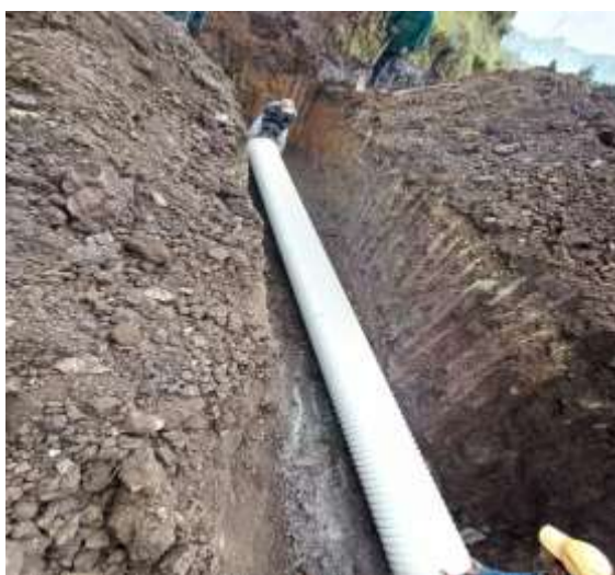
COLOCACIÓN DE ALCANTARILLADO DE AGUAS LLUVIAS COMUNIDAD CACHISAGUA
