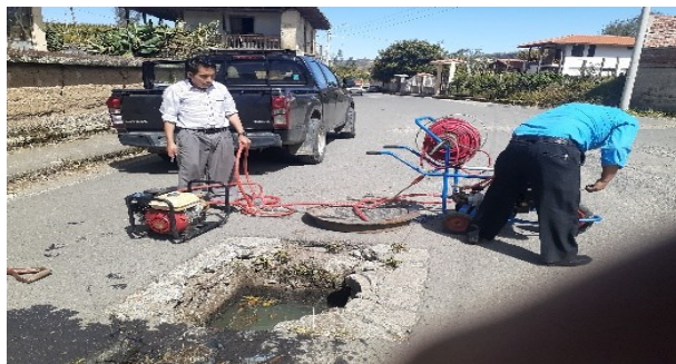
Trabajo de limpieza alcantarillado Barrio San Vicente.
