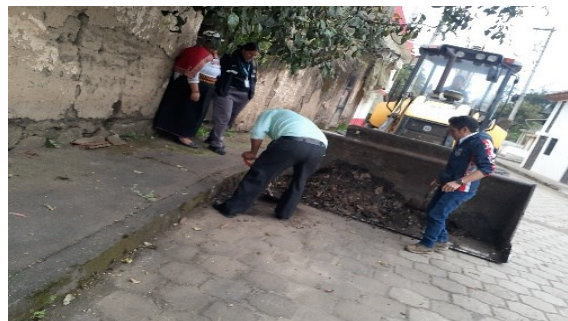
Trabajo de limpieza y fumigación de la cuneta.
