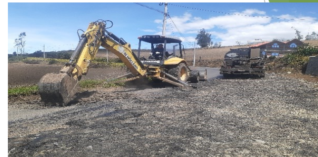
Acompañamiento de trabajos de bacheo de la vía San Simón - Guaranda.
