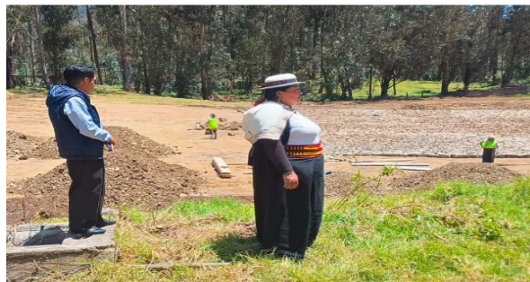
Recorrido y verificación de la construcción parque de la familia.
