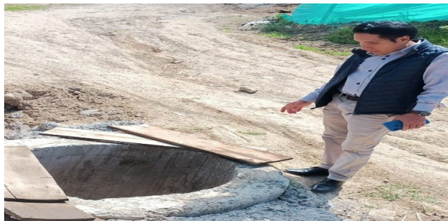
Supervisión de construcción de alcantarillados en el barrio San Vicente.
