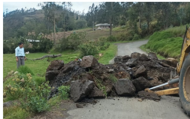
Minga colocación de Tubo vía paso lateral.
