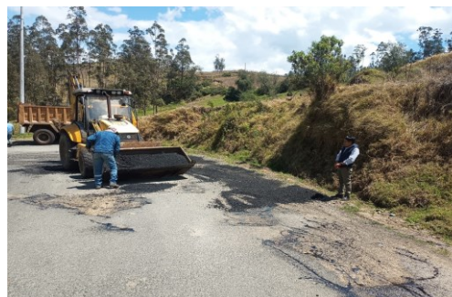
Acompañamiento de trabajos en bacheo de la vía la batea a San Simón.
