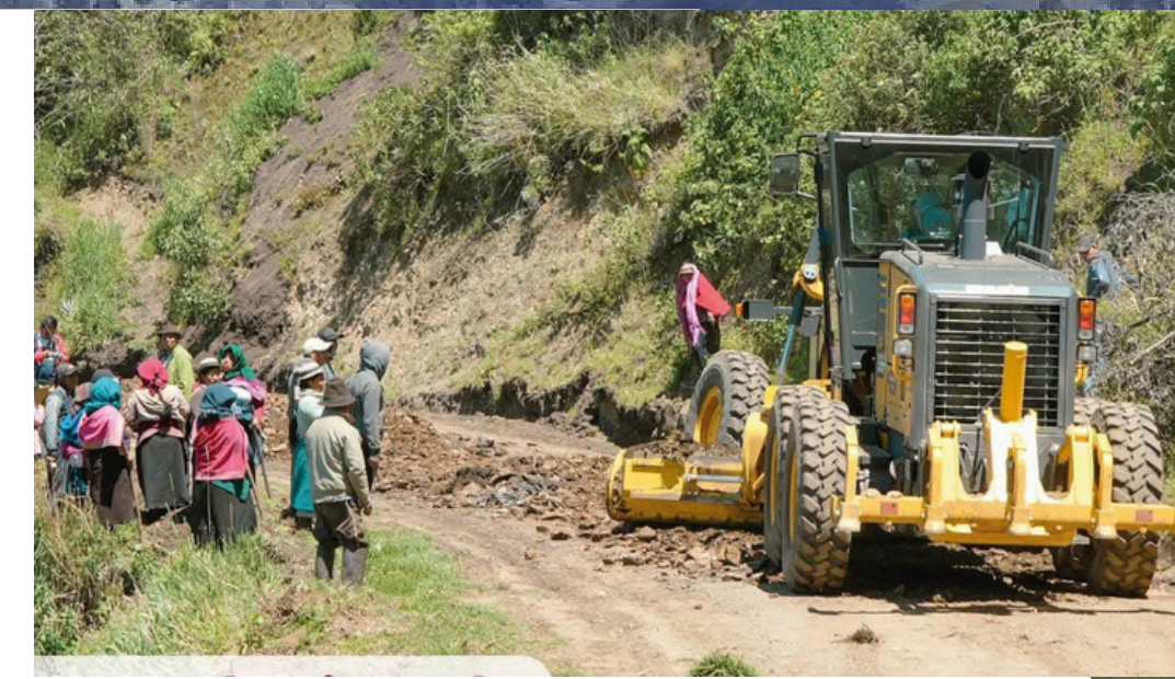
Seguimiento y acompañamiento de maquinarias en mantenimiento de vías en la comunidad de Shulala
