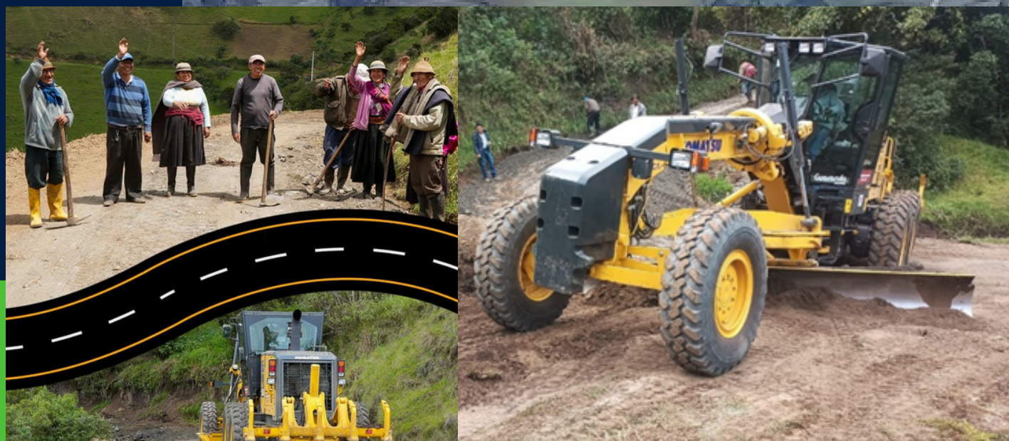
Seguimiento y acompañamiento de maquinarias en mantenimiento de vías en la comunidad de Potrerillo.
