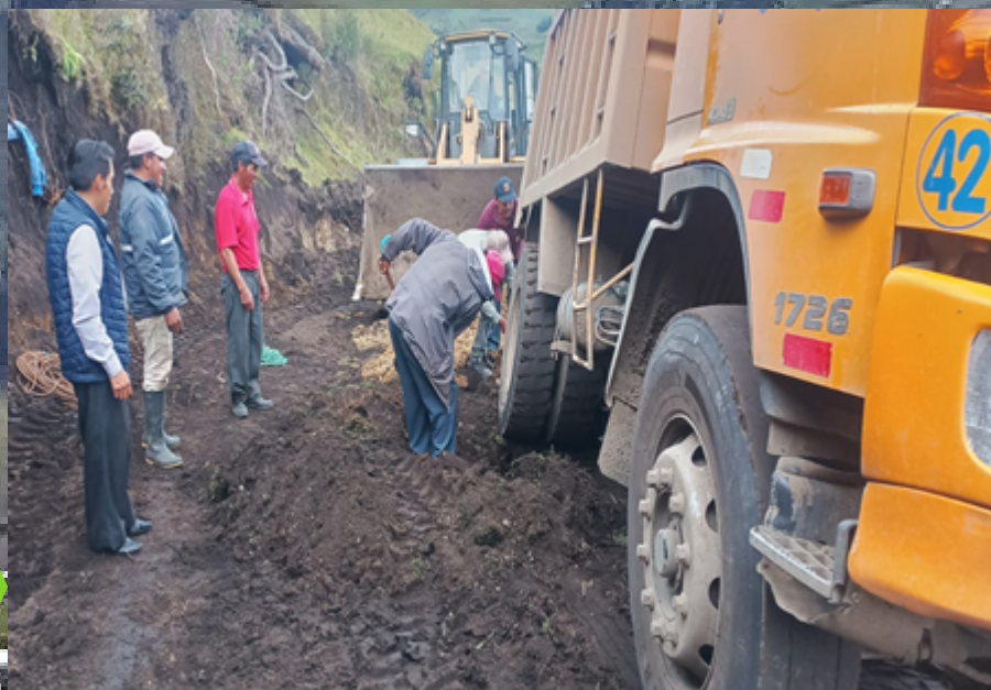
Seguimiento y acompañamiento de maquinarias en mantenimiento de vías en la comunidad de Cachisagua.
