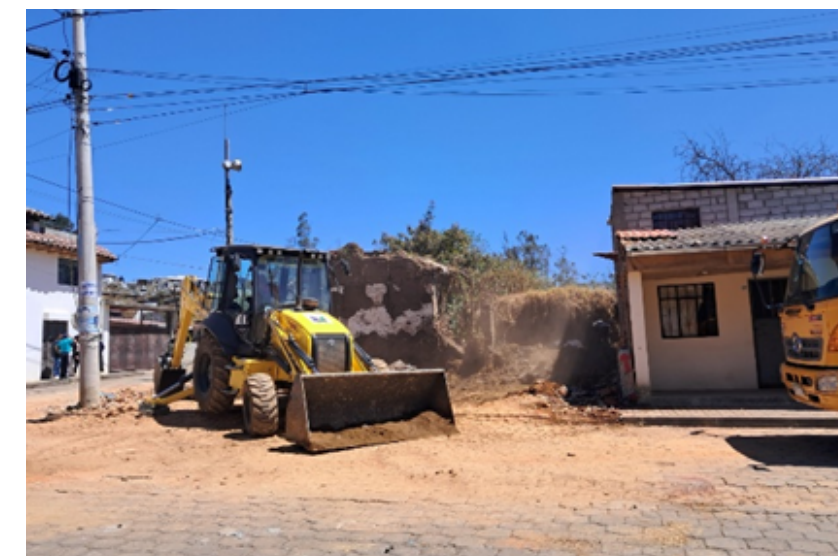
Participación en la minga de limpieza de escombros para la construcción de nuevo edificio del GADIAPSS.
