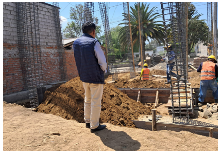
Verificación de avance de la obra de construcción de la casa parroquial
