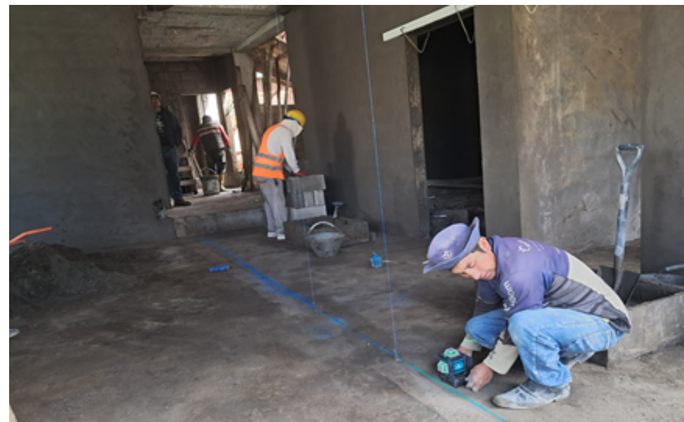
Verificación de avance de la obra de construcción de la casa parroquial.
