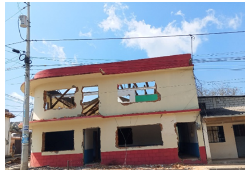
Participación en la minga general de demolición de la casa parroquial para la construcción de nuevo edificio
