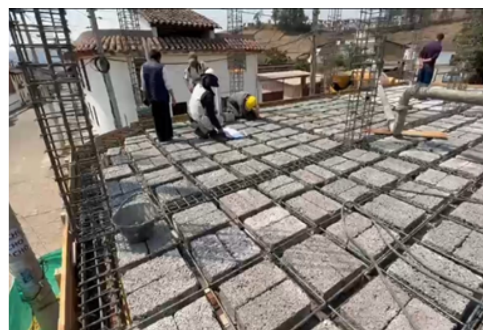
Verificación de avance de la obra de construcción de la casa parroquial.
