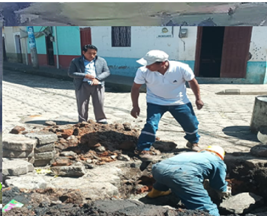
Acompañamiento en construcción de alcantarillado colapsado diagonal al Subcentro de Salud.
