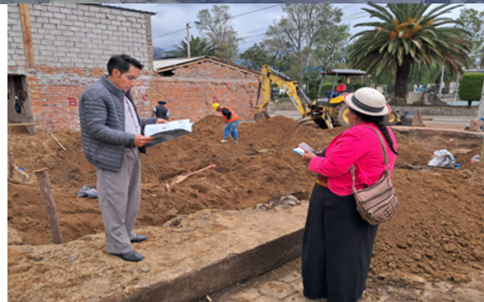
Constatación de trabajo de inicio de la obra casa parroquial.
