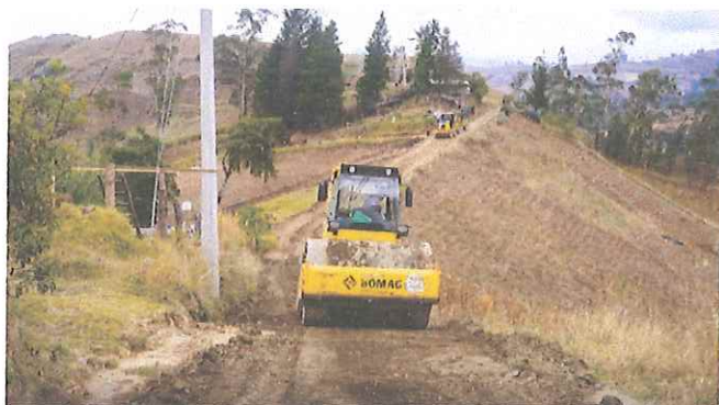
Coordinación de trabajos de vialidad con maquinaria de municipio cantón Guaranda en mantenimiento y rasanteo en Coventillo.
