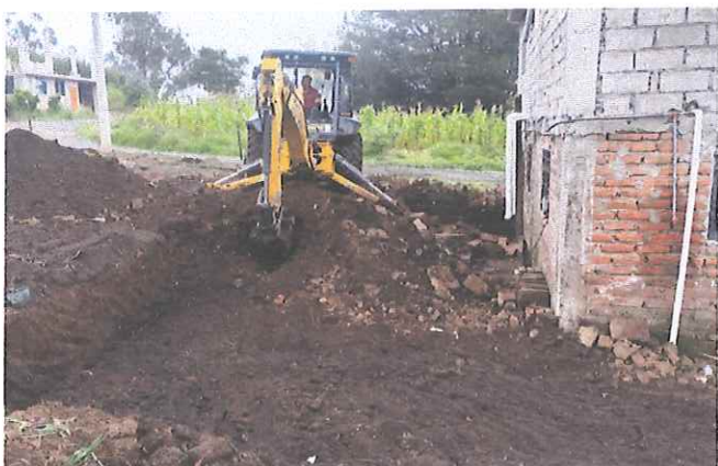
Coordinación y trabajos con la maquinaria en Gradas Central en desalojo de escombros.
