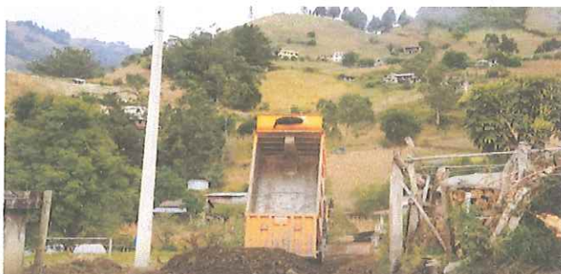
Coordinación de trabajos de vialidad con maquinaria de municipio cantón Guaranda y Cabildo Gradas en Ampliación de vía desde Gradas Central hasta Gradas Chico.
