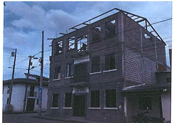
Constatación del avance de la obra de la casa parroquial segunda etapa.
