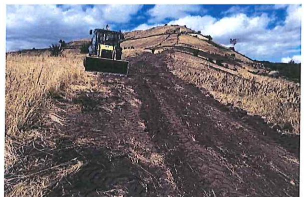
Coordinación y trabajos con la maquinaria en la comunidad de Cachisagua para excavaciones y entierro de tubos de sistema de riego.
