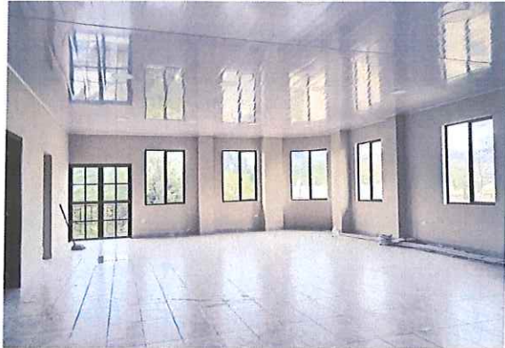
Verificación y constatación de avances de colocación de tumbado de segunda etapa de la casa parroquial
