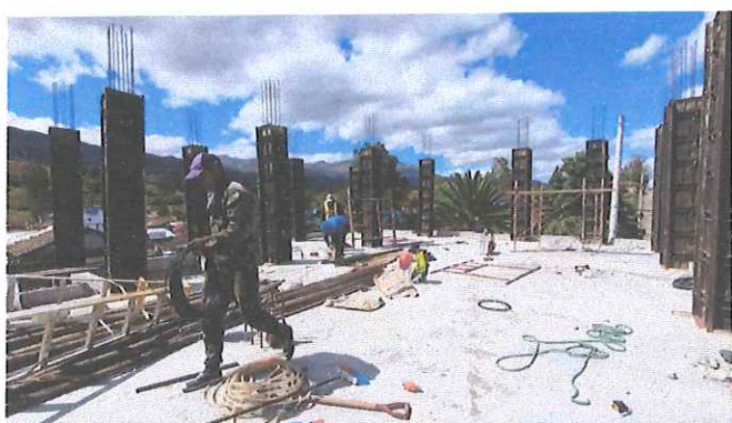
Seguimiento y constatación del avance de la obra de la casa parroquial segunda etapa.
