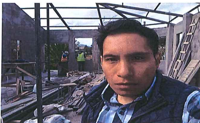
Seguimiento y constatación del avance de la obra de la casa parroquial segunda etapa.
