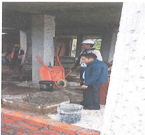
Constatación de avances de trabajos de la obra casa parroquial.
