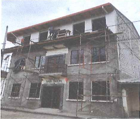
Constatación del avance de la obra de la casa parroquial segunda etapa.
