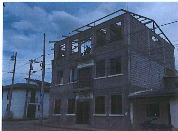
Constatación del avance de la obra de la casa parroquial segunda etapa.
