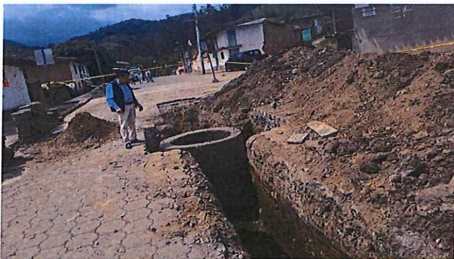
Verificación del avance de la obra de construcción del alcantarillado barrio 3 de mayo.
