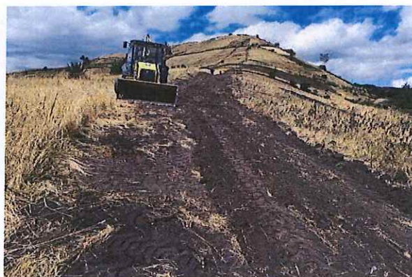
Coordinación y trabajos con la maquinaria en la comunidad de Cachisagua para excavaciones y entierro de tubos de sistema de riego.
