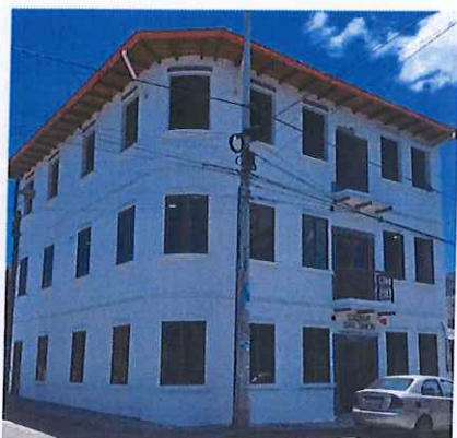
Constatación del avance de la obra de la casa parroquial segunda etapa.
