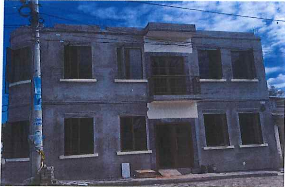
Constatación de trabajos de construcción de la obra casa parroquial.
