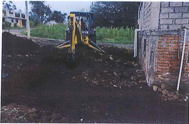
Coordinación y trabajos con la maquinaria en Gradas Central en desalojo de escombros.
