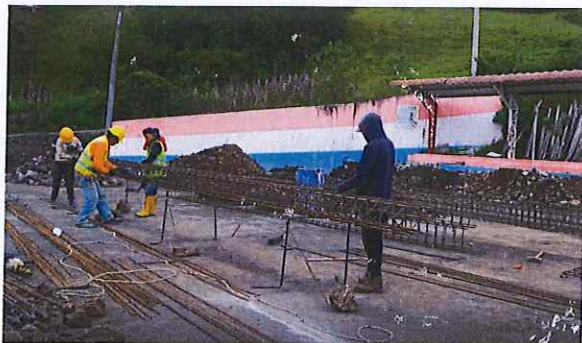
Coordinación y verificación de avances de la obra en la comunidad de Tagma San José realizado por parte del GADC Guaranda.
