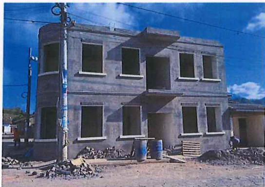
Constatación de trabajos de construcción de la obra casa parroquial.
