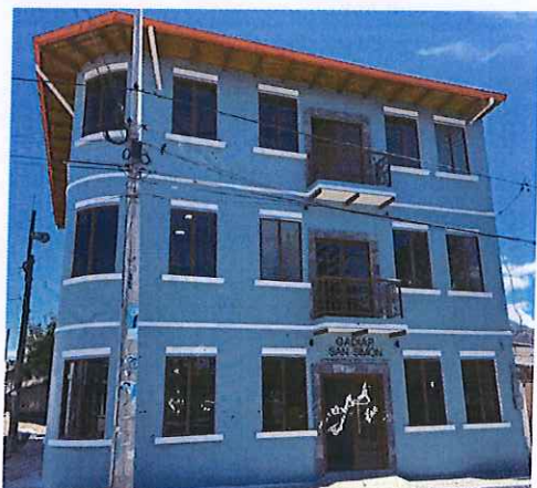
Seguimiento y constatación del avance de la obra de la casa parroquial segunda etapa.
