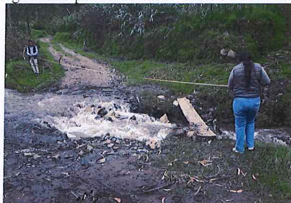
Acompañamiento al técnico de la Prefectura para realizar el Estudio previo construcción cabezales y colocación de tubos, en vía Shacundo – Capito.
