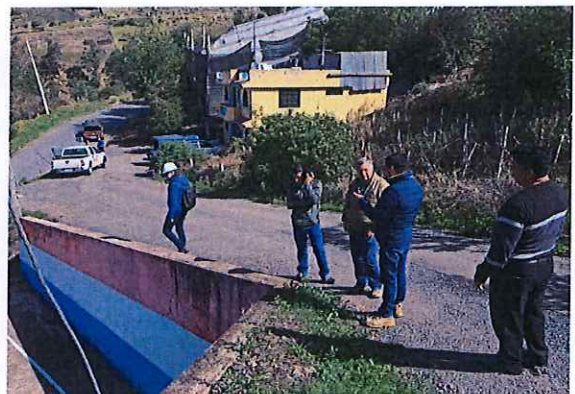
Coordinación de trabajos para la construcción de la cubierta en la comunidad Tagma San José con los técnicos del GADC Guaranda y el Contratista.
