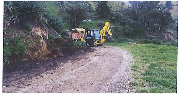
Coordinación de maquinarias en limpieza de la vía en la comunidad de Shulala.
